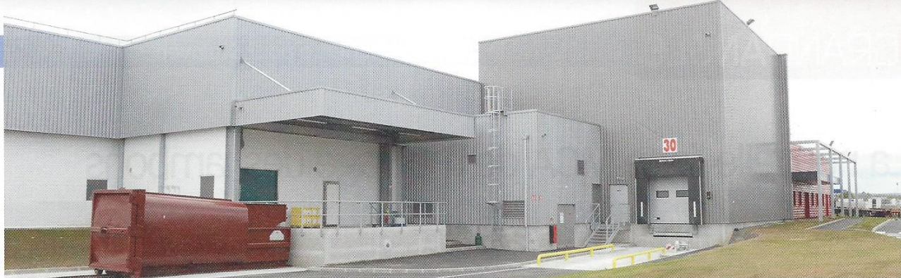
Le quai 30 sert à la réception des produits secs. Les quais 31 et 32 sont dédiés à la réception de viandes. La nouvelle unité « charcuterie » (conception Thébault Ingénierie) est implantée sur le site d'Yffiniac (22), accolée à l'unité « charcuterie pâtissière ».
